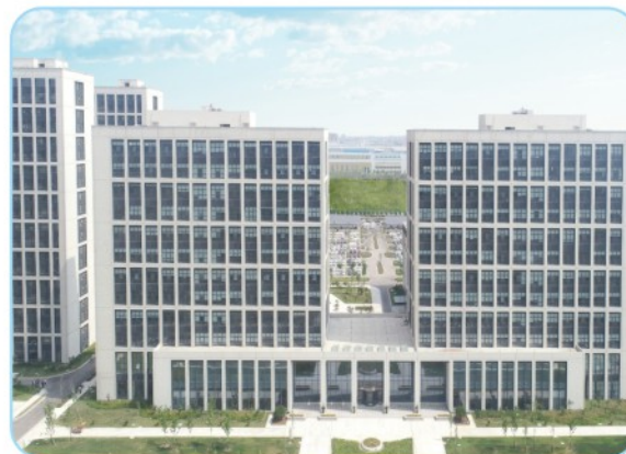
4#A、B研发大楼，12层，建筑面积4.1万平方米
